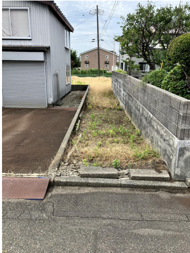
南側通路部分
